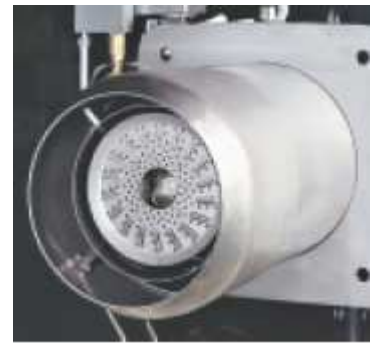
Příklad spalovací hlavy hořáků MODUBLOC MB LE
